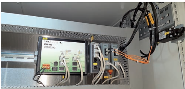
Regulátor budenia generátora v elektrárni Veľké Kozmálovce
