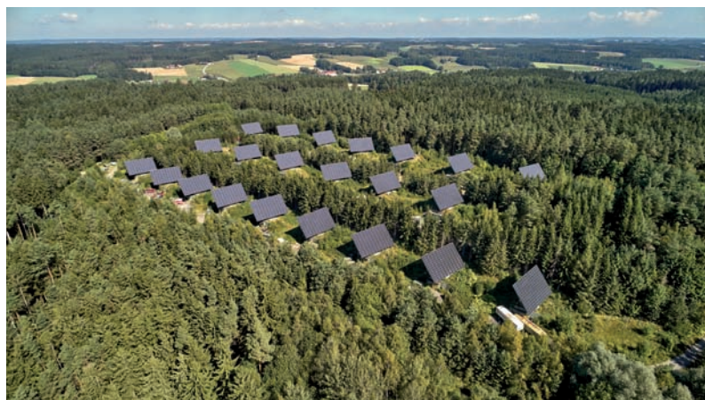
Na bunkroch bývalého vojenského zariadenia je umiestnených 22 sledovačov slnka inštalovaných fotovoltaickými panelmi.
