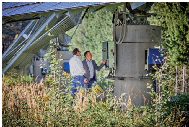
Obr. 2 Každý z fotovoltaických sledovačov má výkon 35 kilowattov.
